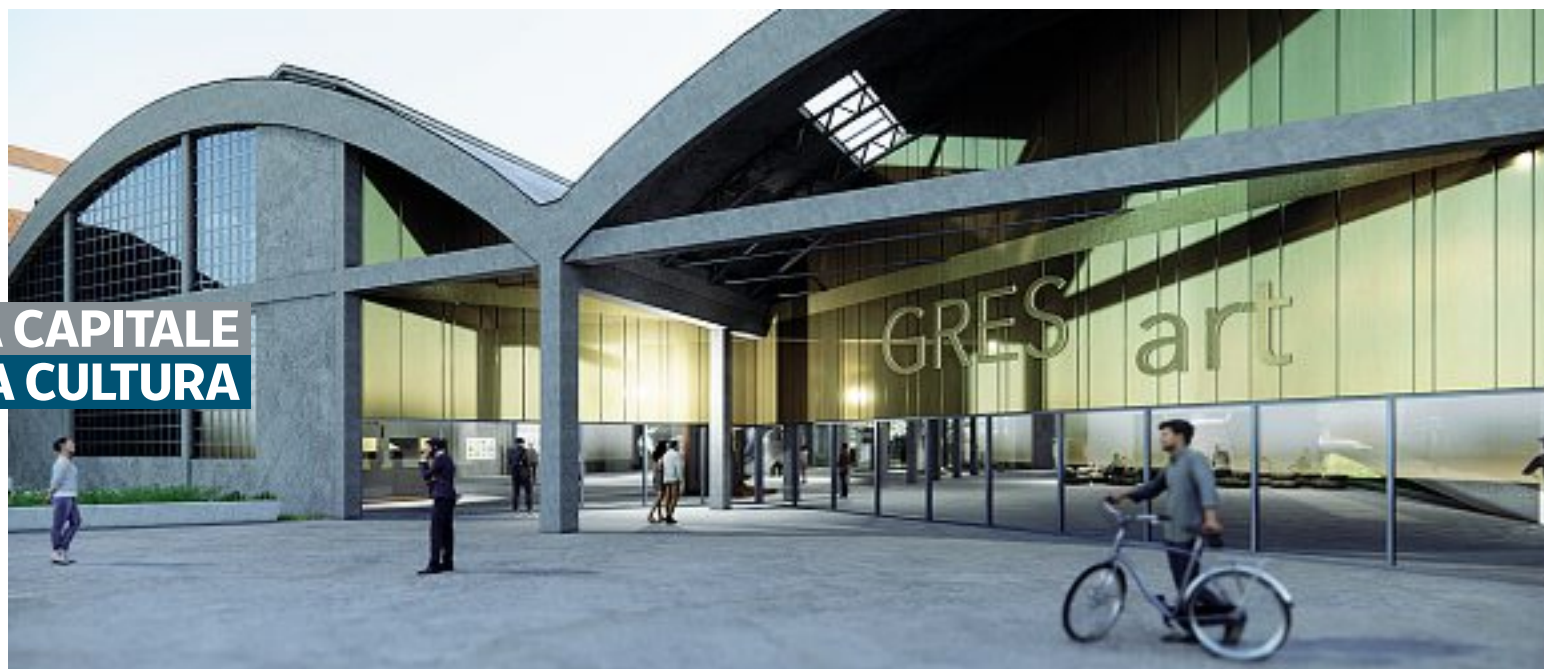
L'entrata Il progetto per Gres Art, negli spazi di via San Bernardino, è stato elaborato dallo studio De8-Architetti
